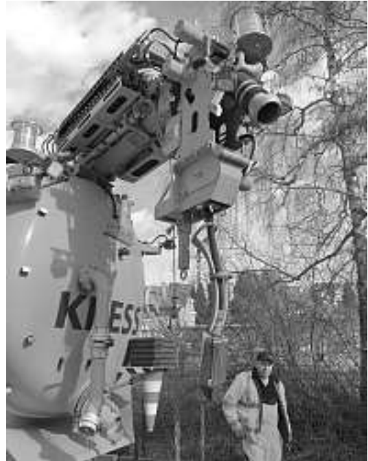
Reinigungsfahrzeug, das zum Spülen der Kanäle vor der Kamerabefahrung eingesetzt wird
